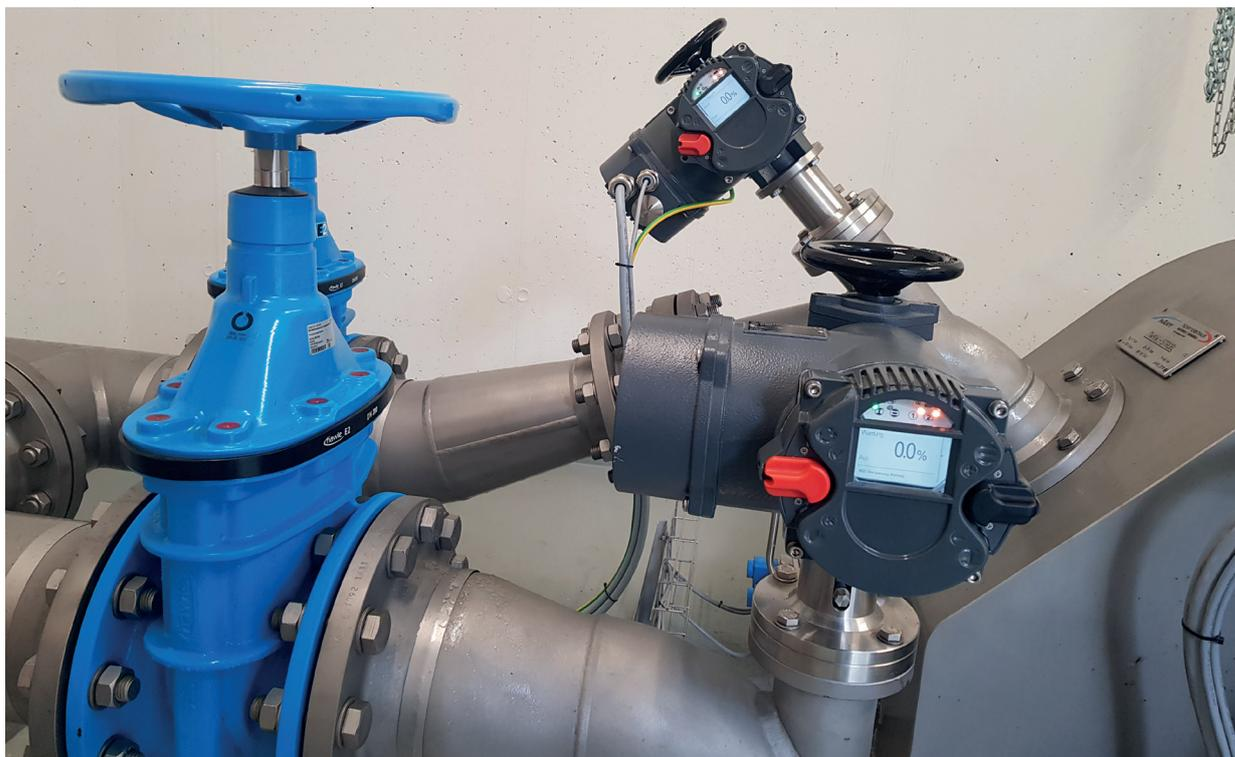
Bild 3: Drehantriebe Type rCM03 mit 24VDC im Trinkwasserkraftwerk Strobl, Österreich
