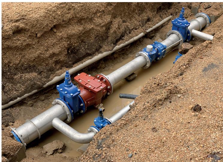
**Bild 1:** Typischer Aufbau einer Versorgungsleitung mit Absperrarmaturen
